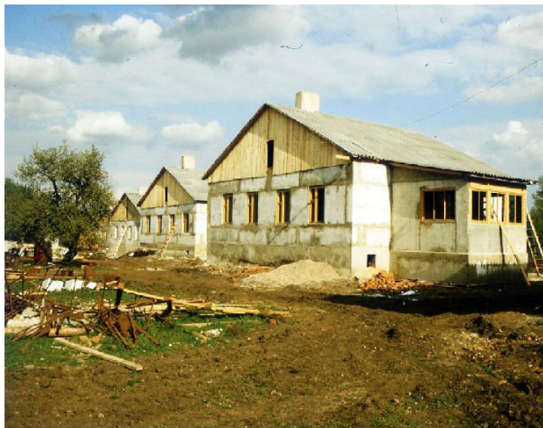
Рис. 1. Строительство домов для переселенцев в с. Архангельское (фото С.А. Иниковой 1990).
